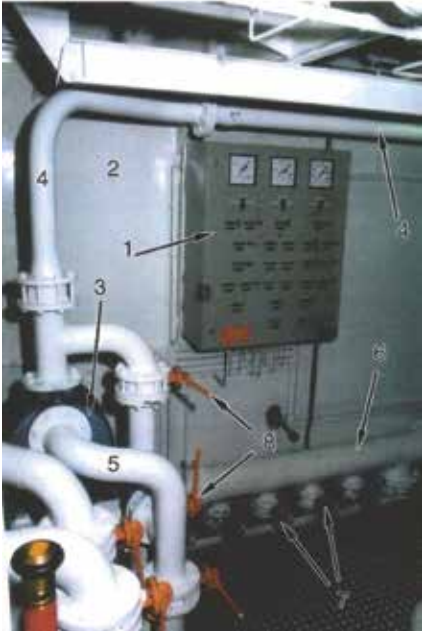
Fig. 6 - Línea de lastre fabricada con fibras sintéticas
